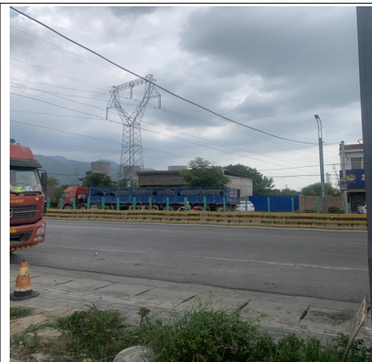
Z4~Z5 号塔基之间跨越 G242 国道处
