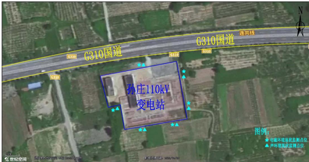
孙庄110kV变电站
