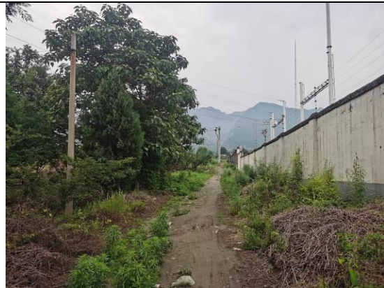
孙庄变110kV出线处
