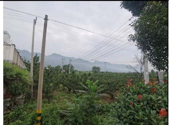
孙庄变电站区西侧
