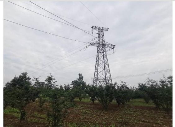
需拆除的110kV少孙线终端塔
