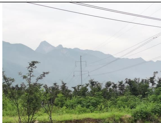
原罗华线31#塔（本期拆除后原址新建）
