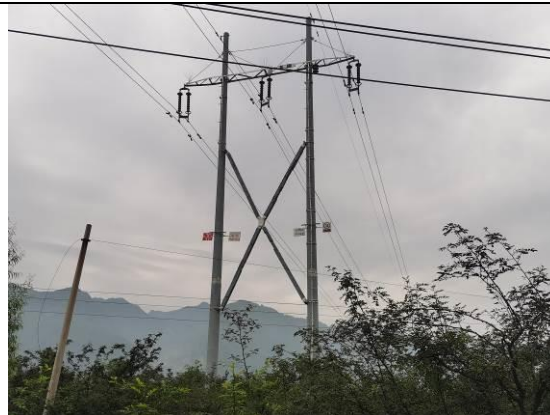
原罗华线30#塔（本期拆除后在原址新建）
